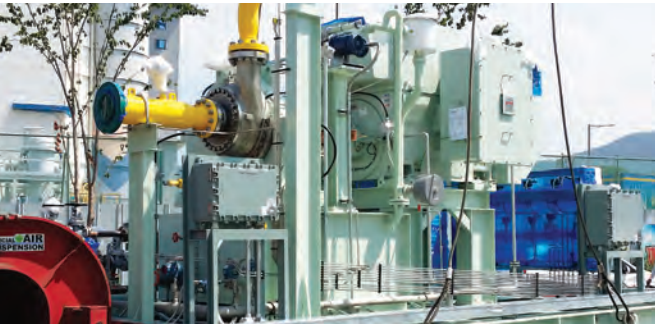
Компрессор топливного газа для ТЭЦ
